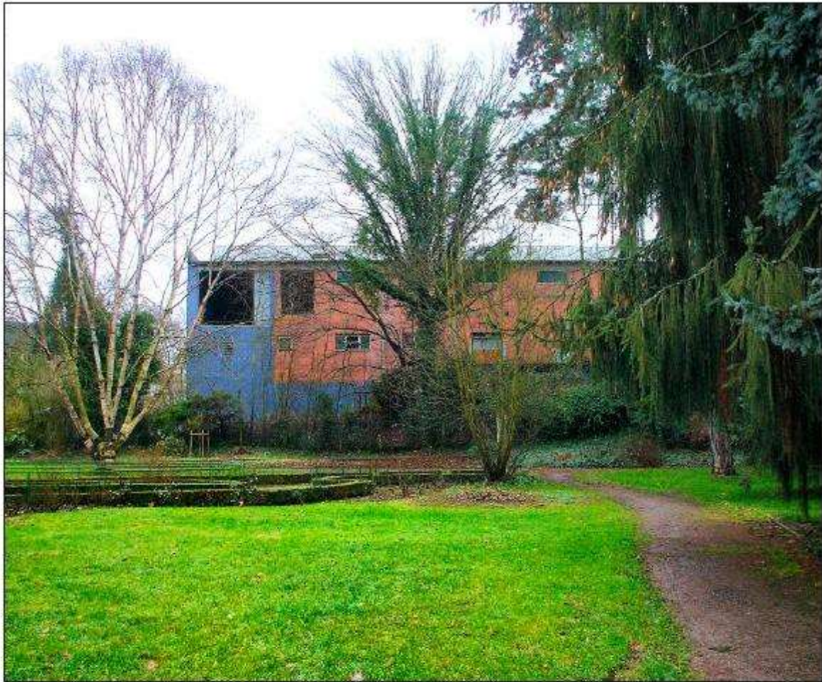
Soll schuld für die Verunreinigungen im alten botanischen Garten sein: Das Gelände der alten Brauerei Marburg im Hintergrund. (Foto: Gütling)
